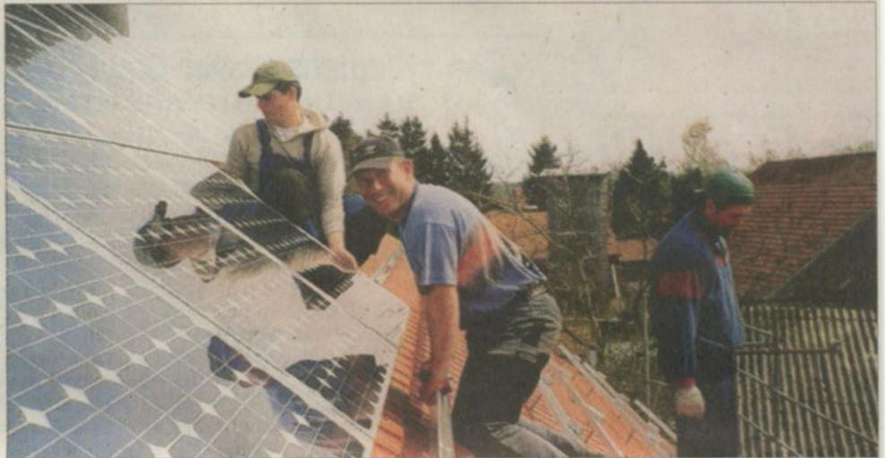
Markus Specht bei der Montage einer Photovoltaikanlage auf einem Einfamilienhaus.
