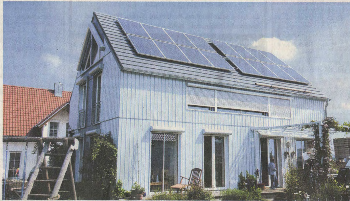
Die Zuschüsse für Solaranlagen auf Dächern sollen ab 1. Juni um 16 Prozent gekürzt werden. Experten raten jetzt, nicht in Panik zu verfallen und überstürzte Anträge zu stellen.
