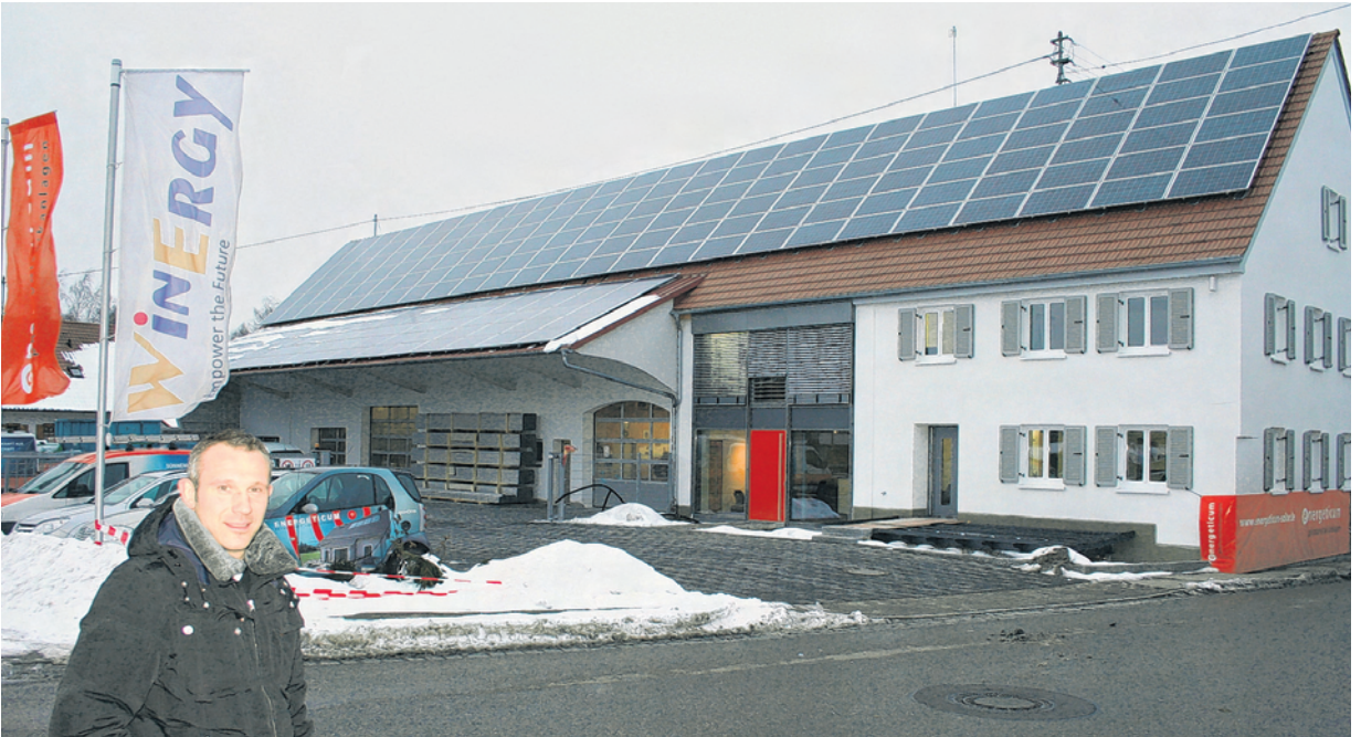
Geschäftsführer Robert Specht vor dem neuen Firmengebäude von Energeticum in Balzhausen. Die Photovoltaikanlage auf dem nach Süden ausgerichteten Dach hat eine Leistung von 50,6 Kilowatt.
